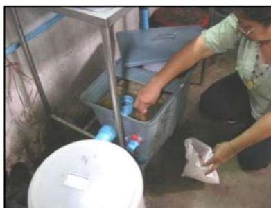
รูปที่ ๓.๑๑ การดักไขมันออกจากถังดักไขมัน
